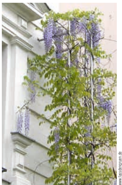
Lineare/räumliche Stahlrohrkonstruktionen als Kletterhilfe für Glyzinie ( Wisteria sinensis )
