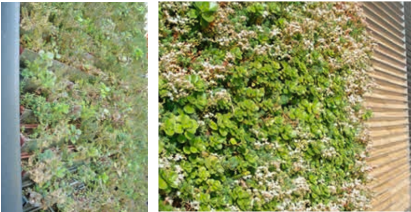
System Fa. Limeparts . Gut erkennbar auf den Abbildungen ist die Schrägstellung der Kassetten. Diese wurden mit Sedumarten bepflanzt und können einzeln ausgetauscht werden.
