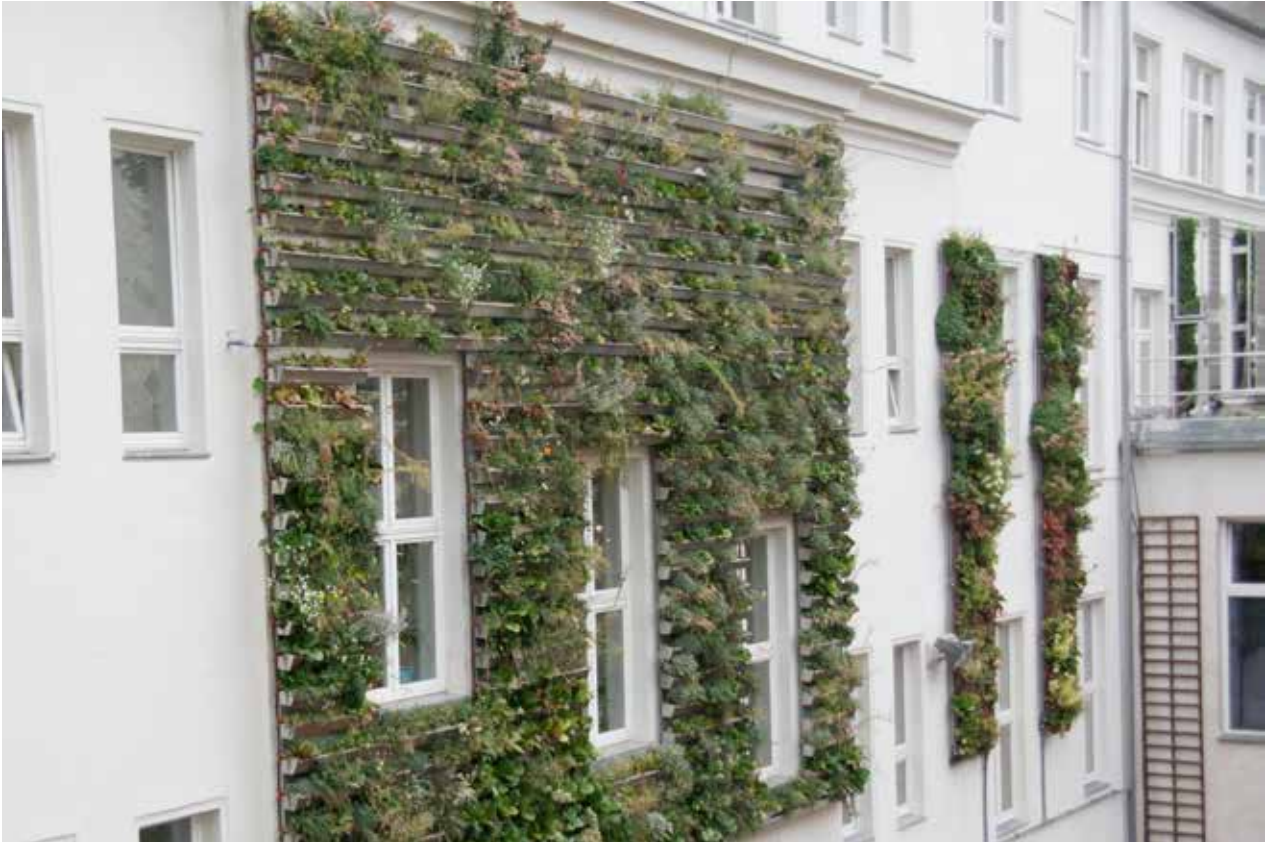
Abb. 21: unterschiedliche Fassadenbegrünungssysteme im Innenhof.
