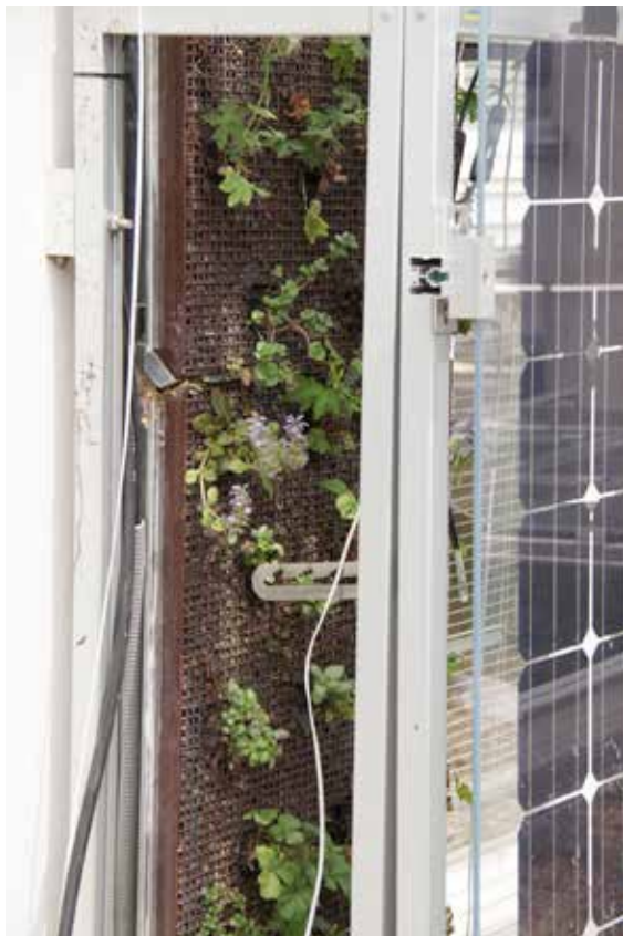
Abb. 46: Kombination von Grünfassade und transluzentem Photovoltaikmodul.
