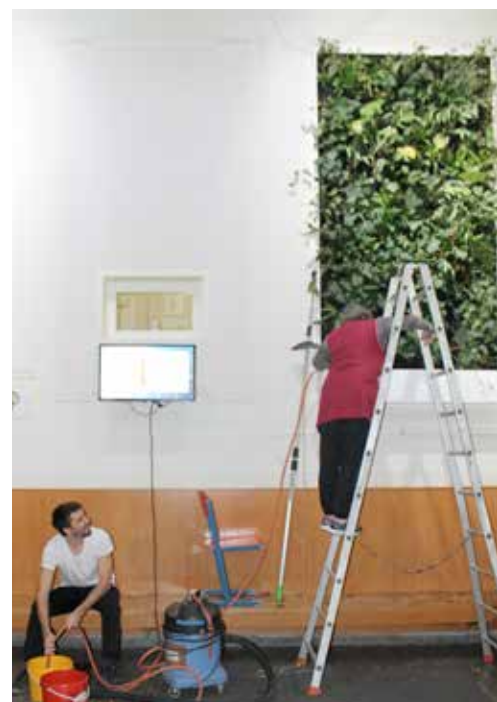
Abb. 18: Reinigung des Wassertanks.
