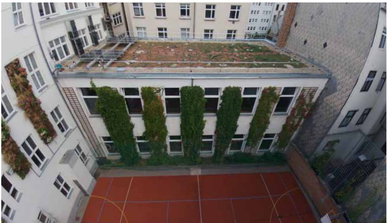
Abb. 1: Dachbegrünung mit vertikaler und horizontaler Photovoltaik und Innenhof mit verschiedenen Arten der Fassadenbegrünung.
