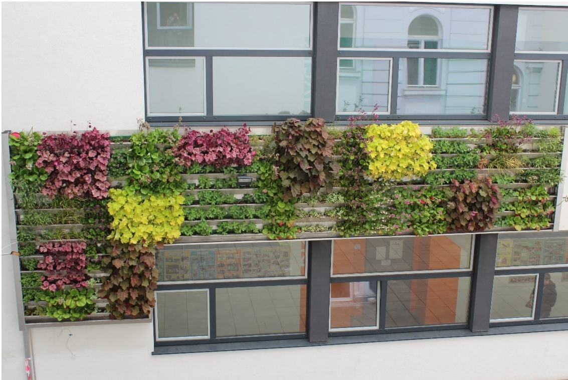
Abbildung 6: Trogsystem im Innenhof BRG16
