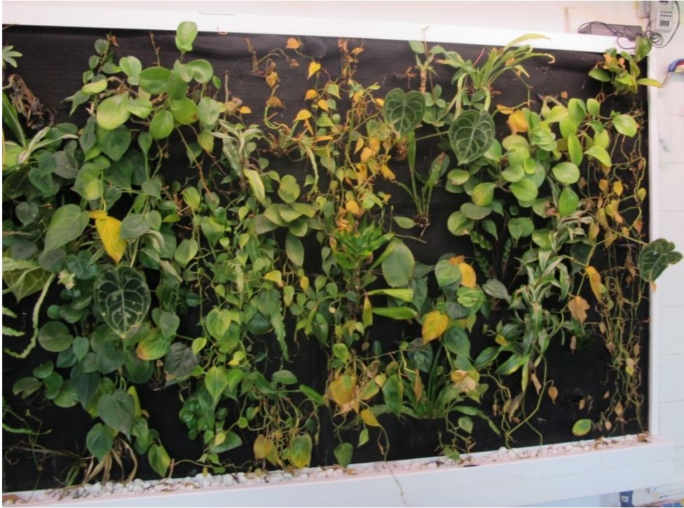
Abbildung 3: Trockengefallenes Vliessystem mit vielen gelben Blättern aufgrund von nicht eingesteckter Bewässerung
